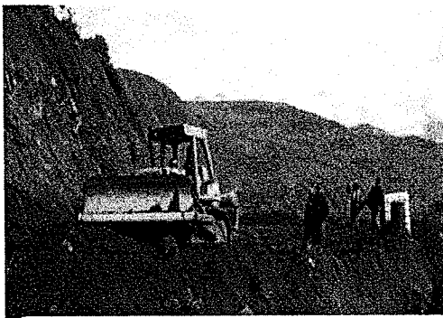
"Mejoramiento de la Carretera Julcamarca y Yanachocce- Chincho – Huanchuy, Anqaraes
